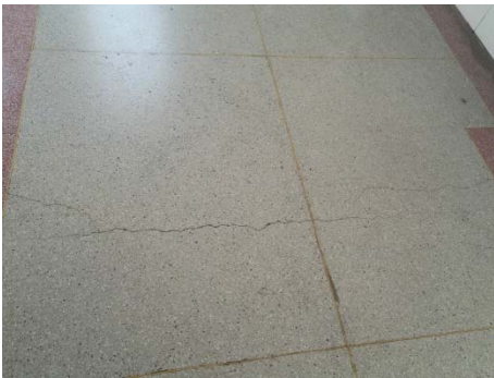
1、2 号楼连廊四层地板 宽约 0.2mm 裂缝
