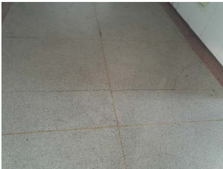
1 号楼 4 层东楼梯间地板 宽约 0.2mm 裂缝
