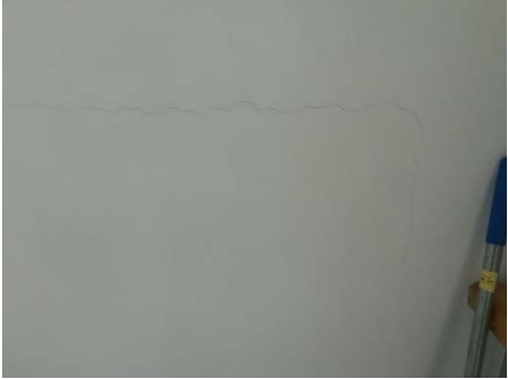
3 层宿舍东面墙存在横向裂缝，房间中段存在竖向贯通裂缝。
