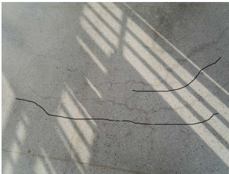
1 号楼 4 层东楼梯间地板 宽约 0.2mm 裂缝
