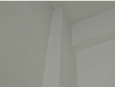
五层半楼梯间位置墙、柱连接处存在竖向裂缝，柱侧存在斜向裂缝
