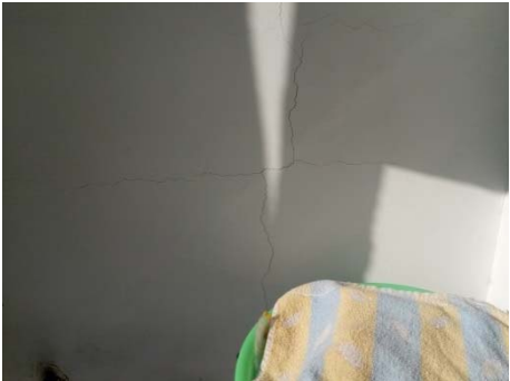
2 层宿舍阳台门上存在宽 1mm 竖向裂缝，阳台东面墙存在横向竖向裂缝。
