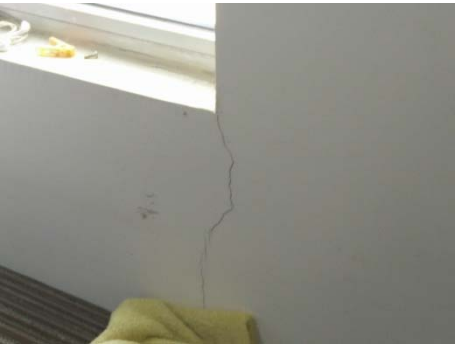
一层 106 室西侧窗洞口位置内墙处存在窗台下沿通至地面的竖向裂缝
