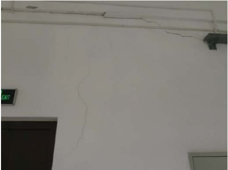
1 层餐厅房间上方存在宽约 2mm 的较长竖向裂缝。
