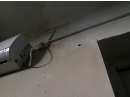
1 层配电室北侧门上存在宽约 2mm 斜裂缝
