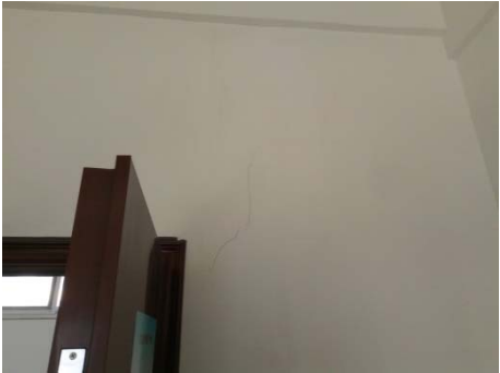
1 层楼梯间西侧墙存在宽约 1mm 的竖向横向裂缝。
