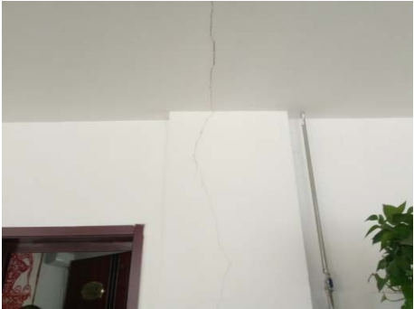
1 层餐厅房间上方存在宽约 2mm 的较长竖向裂缝。
