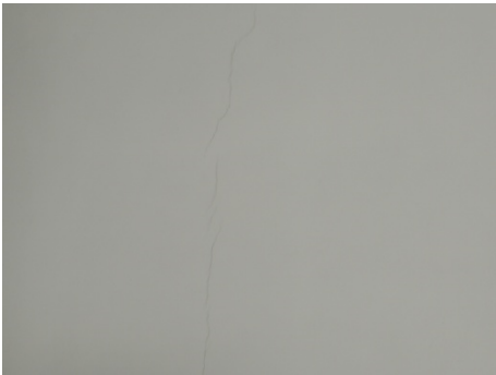
203、303、308、309、416、417、413、407、403、402、509、513、515 室外走廊位置内墙处存在地面通至顶板的通长裂缝
