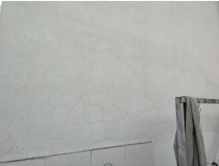
西侧墙体存在多处网状裂缝宽度约 1~2mm
