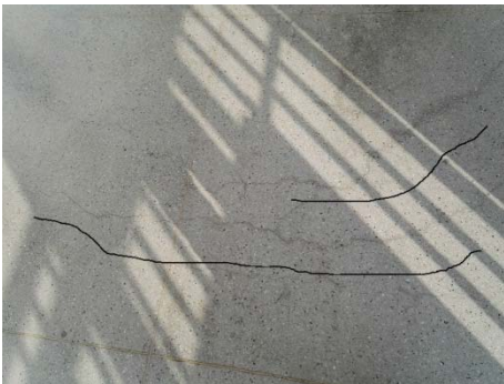
1、2 号楼连廊四层地板 宽约 0.2mm 裂缝
