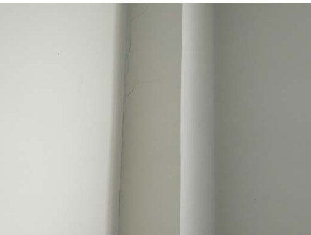
一层 106 室南、北两侧墙、柱连接位置处存在竖向裂缝，柱侧存在多道斜向裂缝
