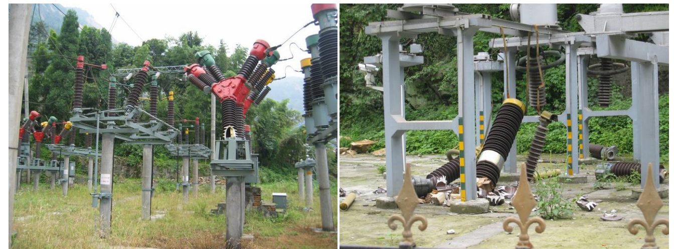
图 4.1-2 地震中倾倒的断路器和隔离开关
