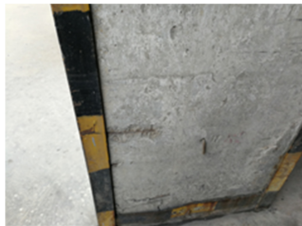
图 4.1-4 柱钢筋外露
