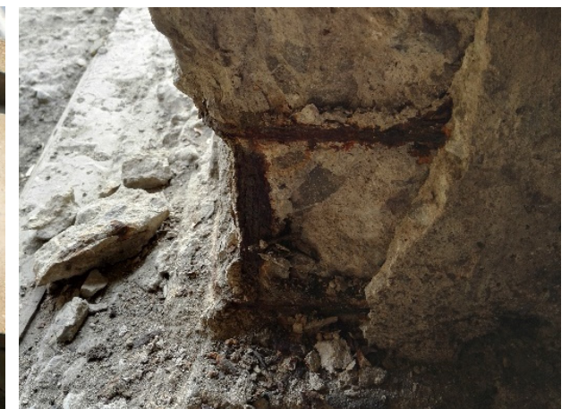
图 4.2-3 侧面混凝土脱落，钢筋外露
