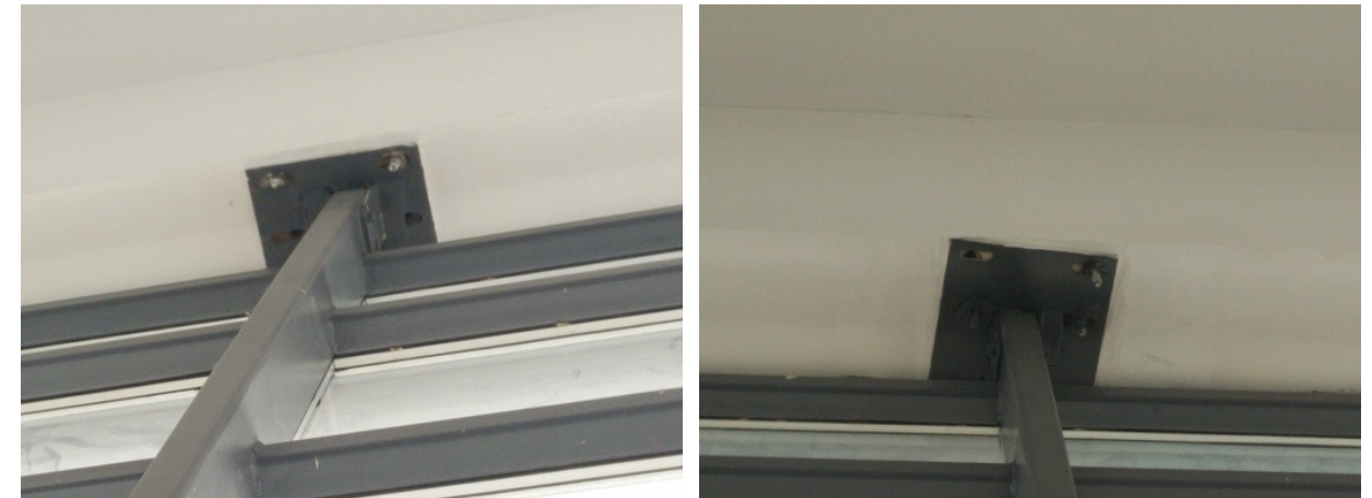
图 4.8-1 螺栓锚固情况
