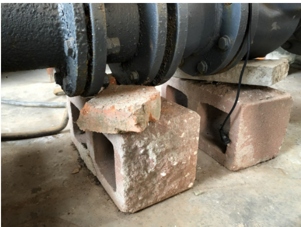
图 4.3-3 抽水泵管与基础锚固情况
