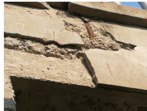
图 4.2-3 侧面混凝土脱落，钢筋外露
