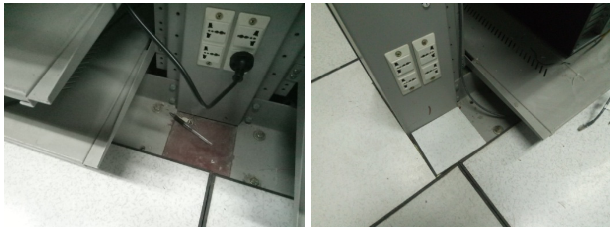
图 4.7-5 内部通讯设备锚固情况
