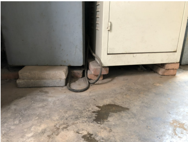
图 4.3-1 机电设备锚固情况
